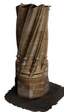
Figura 8 – Columna de la Lonja modelada en 123D Catch y exportada a 3ds Max
